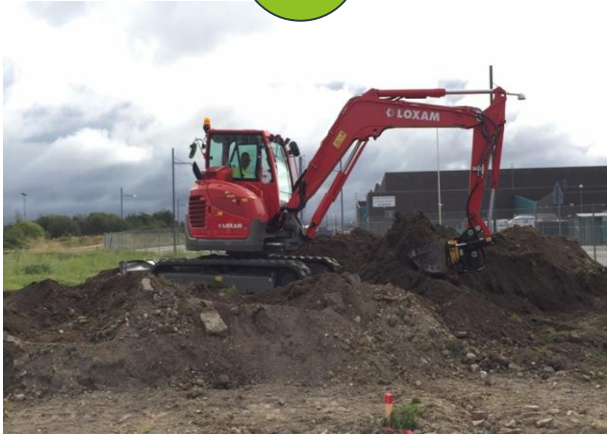
Udgravning til fundament
