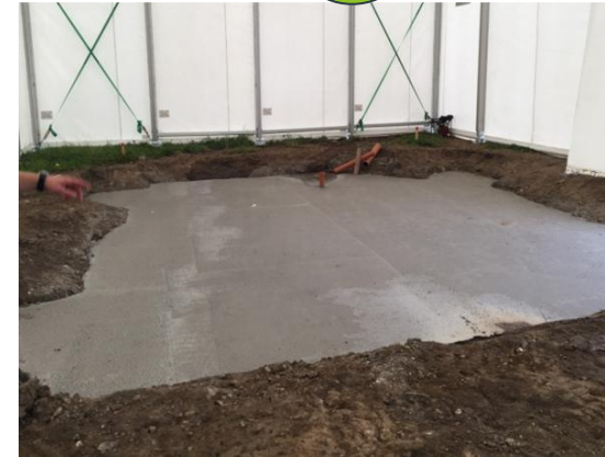
Støbning af pladefundament
