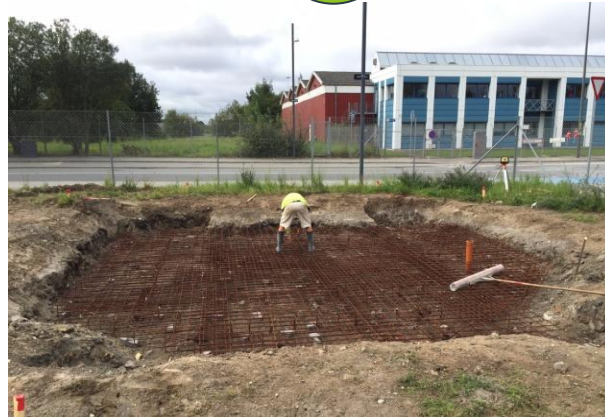
Armering til fundament + pælefundering
